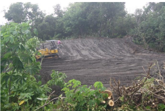
Gambar 7. Pembukaan lahan untuk lokasi tambak udang yang baru
