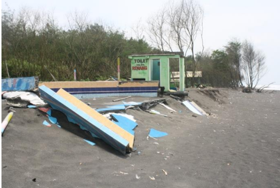
Gambar 11. Bangunan semi permanen yang rusak terkena abrasi
