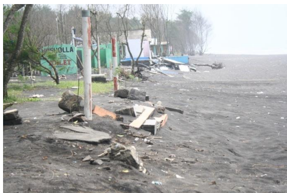
Gambar 13. Abrasi pantai akibat hempasan gelombang laut yang tinggi dan energi besar
