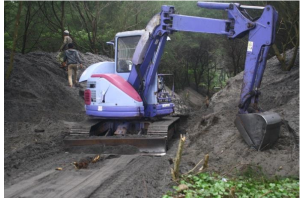
Gambar 8. Pembukaan lahan untuk membuat saluran air tambak udang ke laut menggunakan alat berat
