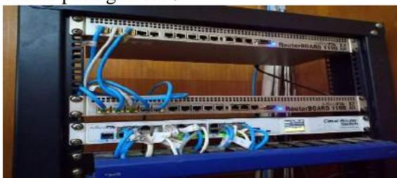
Gambar 9. Kondisi *router gateway* (atas), distribusi (tengah) dan *switch core* (bawah) jaringan UKRIM
