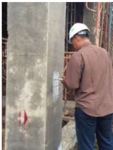
Gambar 4.1 Uji Hammer Test Pada Kolom
