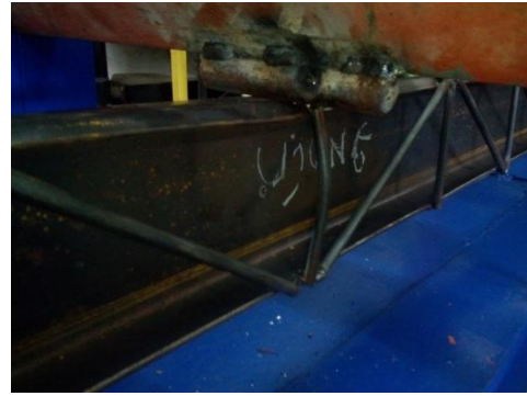
Gambar 8. Buckling pada tulangan perkuatan
