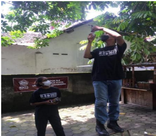
Gambar 2. Aktifitas Pemasangan Instalasi Listrik
