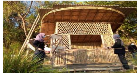
Gambar 7. Pembangunan Warung UMKM
