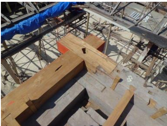
Gambar 5. Gandamaru yang terpasang pada balok tumpangsari
