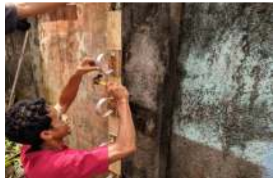
Gambar 8. Pipa PVC yang sudah terpasang pada kayu dan siap di tanam.
