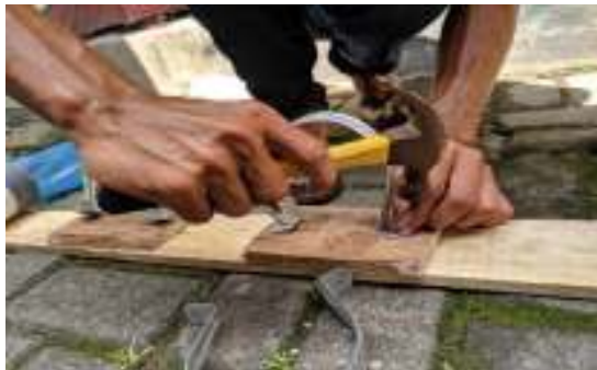
Gambar 5. Dilubangi dan kayu untuk menahan pipa. Pipa PVC yang telah
