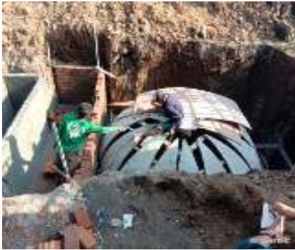
Gambar 2.3 Foto Metode pembuatan plat tutup bak biodigester
