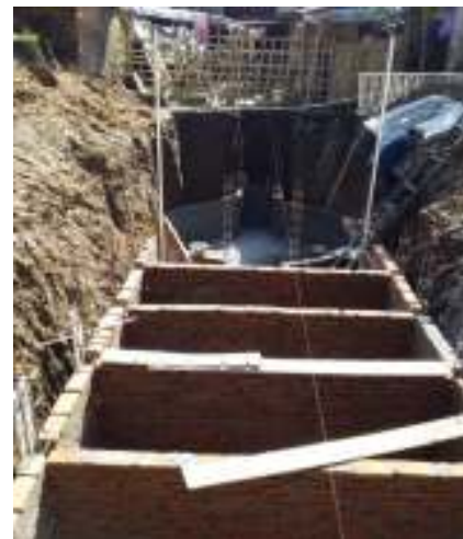
Gambar 2.2 Foto bangunan sekat antar bak satu dengan bak lain.
