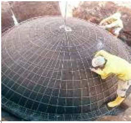
Gambar 2.4 Foto Plat penutup degester sudah siap cor campuran beton
