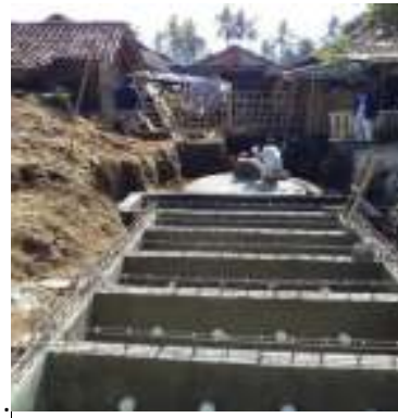
Gambar 2.5 Foto Pemasangan plat penutup bak bio degester dan plesteran semua bak.
