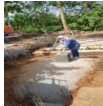
Gambar 2.6 Foto bangunan plat penutup manhole.
