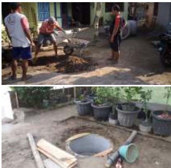
Gambar 1. Pembuatan Biopori Jumbo
