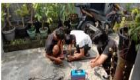
Gambar 7. Kerja bakti mendirikan tiang CCTV
