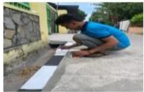
Gambar 8. Kerja bakti mengecat marka jalan
