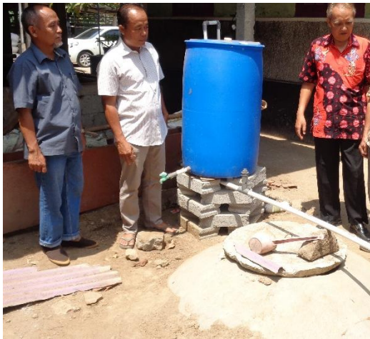
Gambar 1. Digester dan tabung Pupukcair
